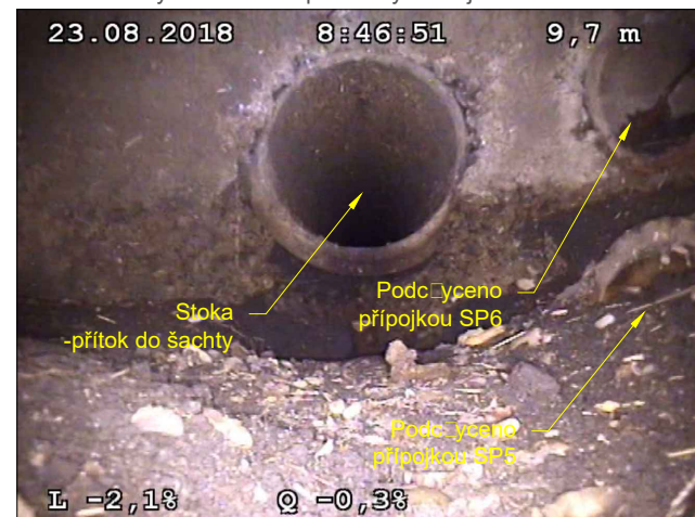
Záběry z kamerové prohlídky stávající kanalizace
